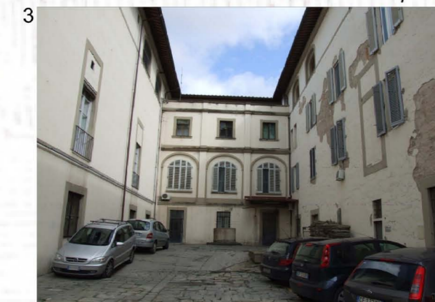
Corte centrale - veduta da Via G. da Empoli
