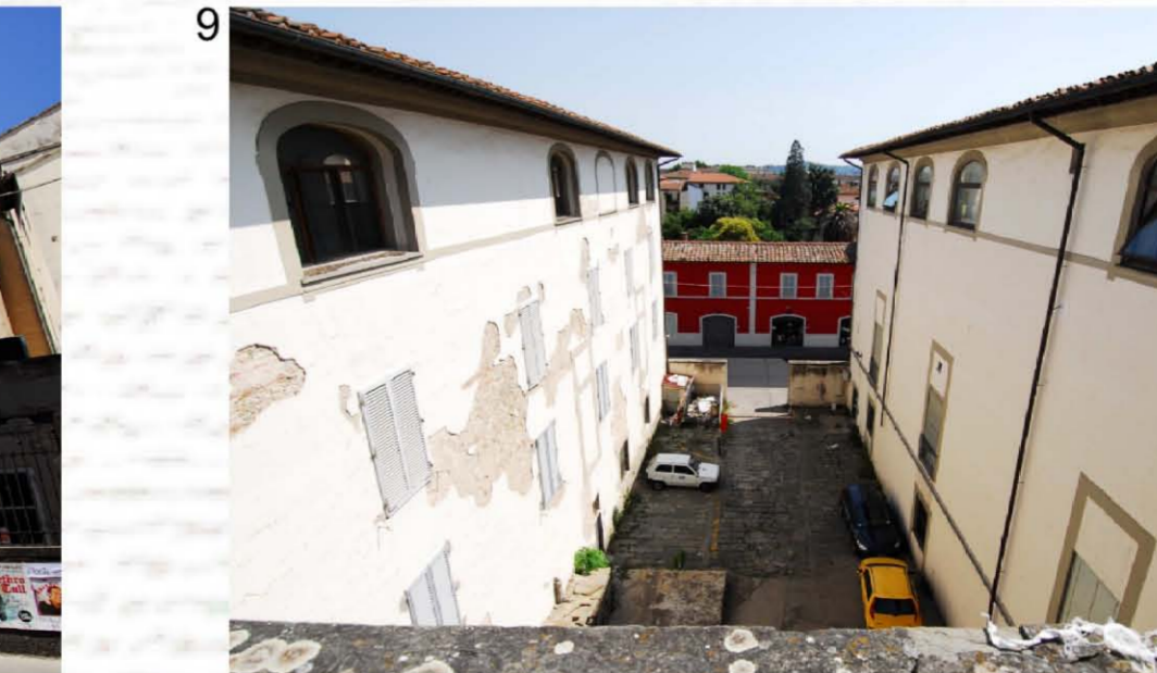
Corte centrale - veduta da terrazzo
