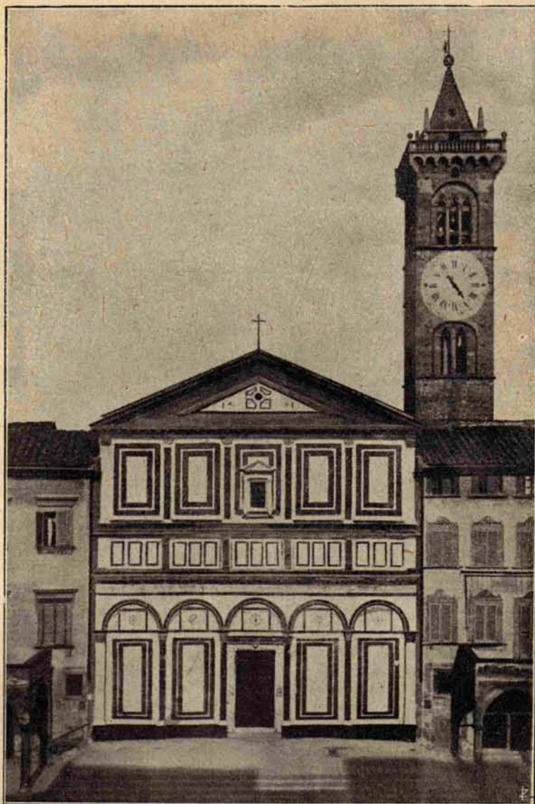
Facciata dell'insigne Collegiata, chiesa dedicata a Sant'Andrea apostolo, costruita nel 1093, a cinque arcate, in marmo bianco e verde-nero; la parte superiore col timpano si deve a Ferdinando Ruggeri (1738). Il campanile è di architettura romanico-gotica a cuspidè piramidale.
